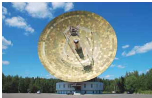
Радиотелескоп ТНА-1500. В настоящее время - Станция управления КА в дальнем космосе в S, C и X-диапазонах
